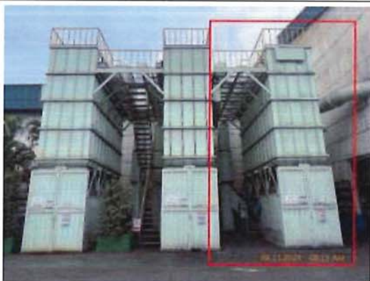
ภาพที่ 9 ปล่องระบบดักฝุ่นจาก Drum Cooler No.2 (Line AMF)
