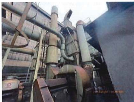
ภาพที่ 5 ปล่องระบบดักฝุ่นจาก Molding line (Line ACE)
