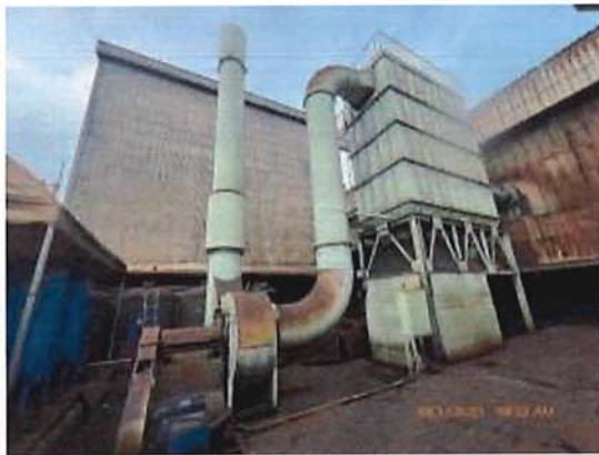
ภาพที่ 3 ปล่องระบบดักฝุ่นจาก Finishing & Grinding (Line ACE)
