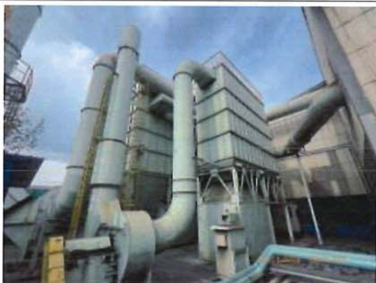
ภาพที่ 11 ปล่องระบบดักฝุ่นจากบริเวณพื้นที่เตาหลอม
