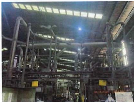
ภาพที่ 15 ระบบดูดอากาศ (ป้องกันการฟุ้งกระจายของฝุ่นทราย)
