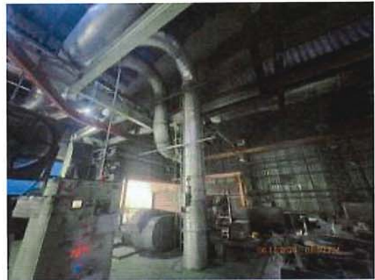
ภาพที่ 14 ระบบรวบรวมไอน้ำ (ในชั้นตอนเติมแมกนีเซียมในเบ้าน้ำเหล็ก)
